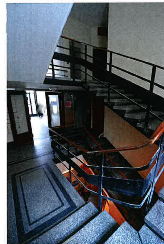
widok ogólny klatki schodowej w poziomie parteru
