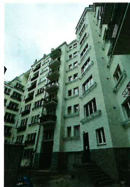
elewacje od podwórza - stan po remoncie
