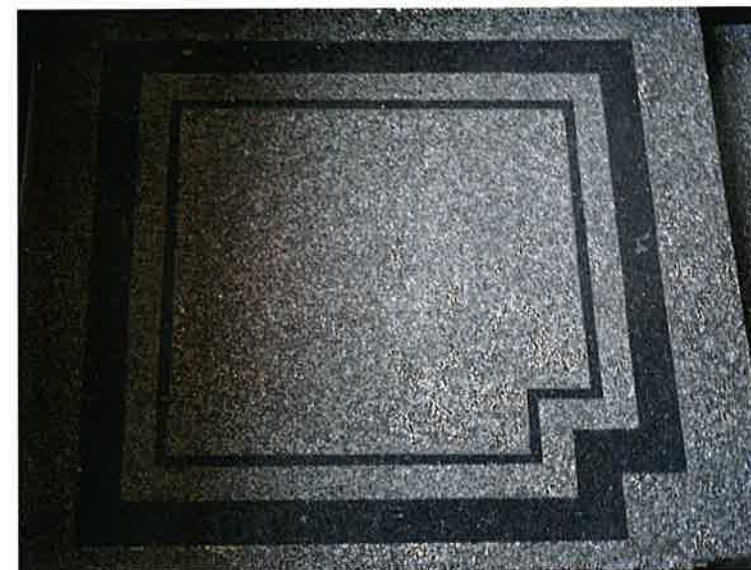
lastrykowe wykończenie spocznika pośredniego
