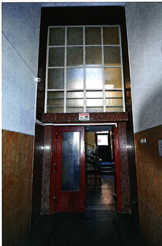
Sień wejściowa i oryginalne drzwi; obok: fragment ściany wokół drzwi z pierwotną okładziną z wapienia "Morawica" zestawiony z wtórnym wykończeniem z granitu
