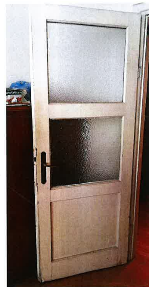
stolarka drzwiowa w jednym z mieszkań
