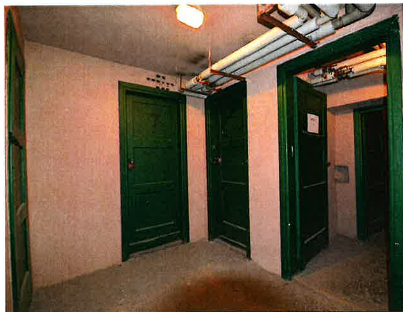
komórki lokatorskie w piwnicach
