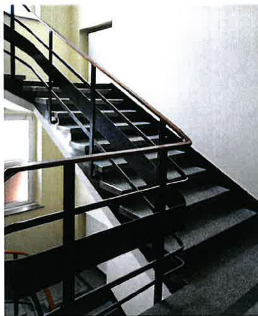
widok schodów i balustrady
